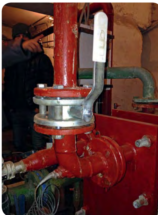
КОНТУР ГВС ПОСЛЕ ПЛАСТИНЧАТОГО ТЕПЛООБМЕННИКА
