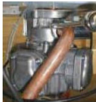
9) С помощью гаечного ключа 13 мм отсоедините три удерживающих болта на опорном кронштейне над счётчиком.
